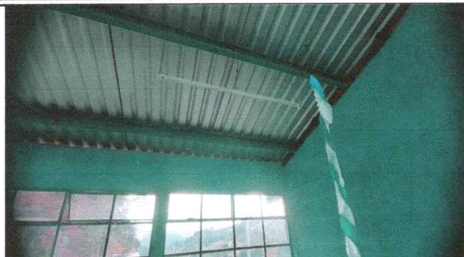
Foto 8: Instalacion de plafonera, en el area de aulas, marca aguila
