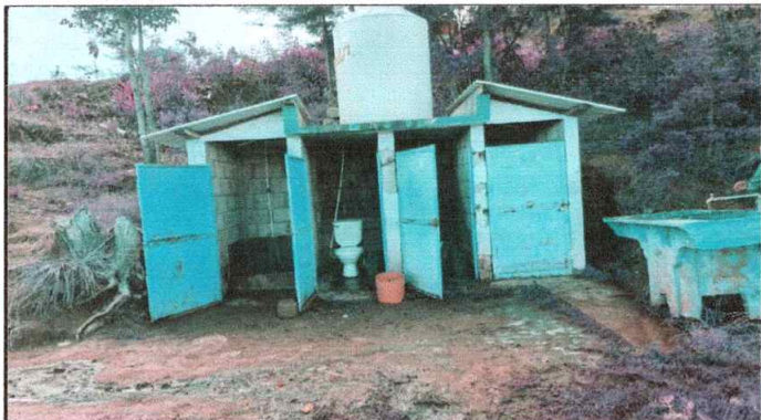
Foto 1: Sustitución de puertas de metal, en el área de baños, incluye pintura anticorrosiva, pasador de metal.
