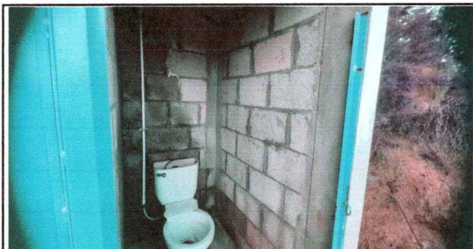
Foto 6: Sustitución de inodoros, en el área de baños marca aldosa
