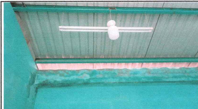
Foto 9: Instalacion de lamparas tipo LED, en el area de aulas, marca voltin de 60 W
