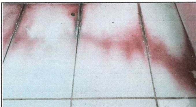
Foto 10: Sustitucion de azulejos en el area de baños marca hispacensa
