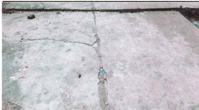
Foto 3: Sustitución de torta de concreto en el área de patio con espesor de 10 cm.
