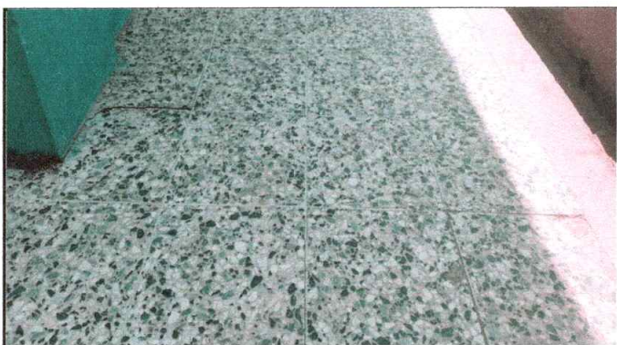
Foto 4: Sustitución de piso granito de 30x30 en área de aulas
