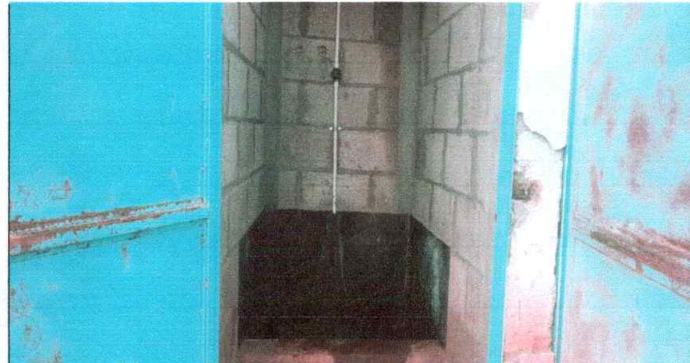
Foto 7: Instalación de Migitorio en el área de baños, marca aldosa
